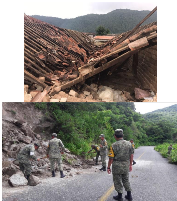
Figura 1.2. Aspectos generales del sismo de 7 de septiembre de 2017 (fotos cedidas por la Secretaria de protección Civil, Chiapas, 2017).
