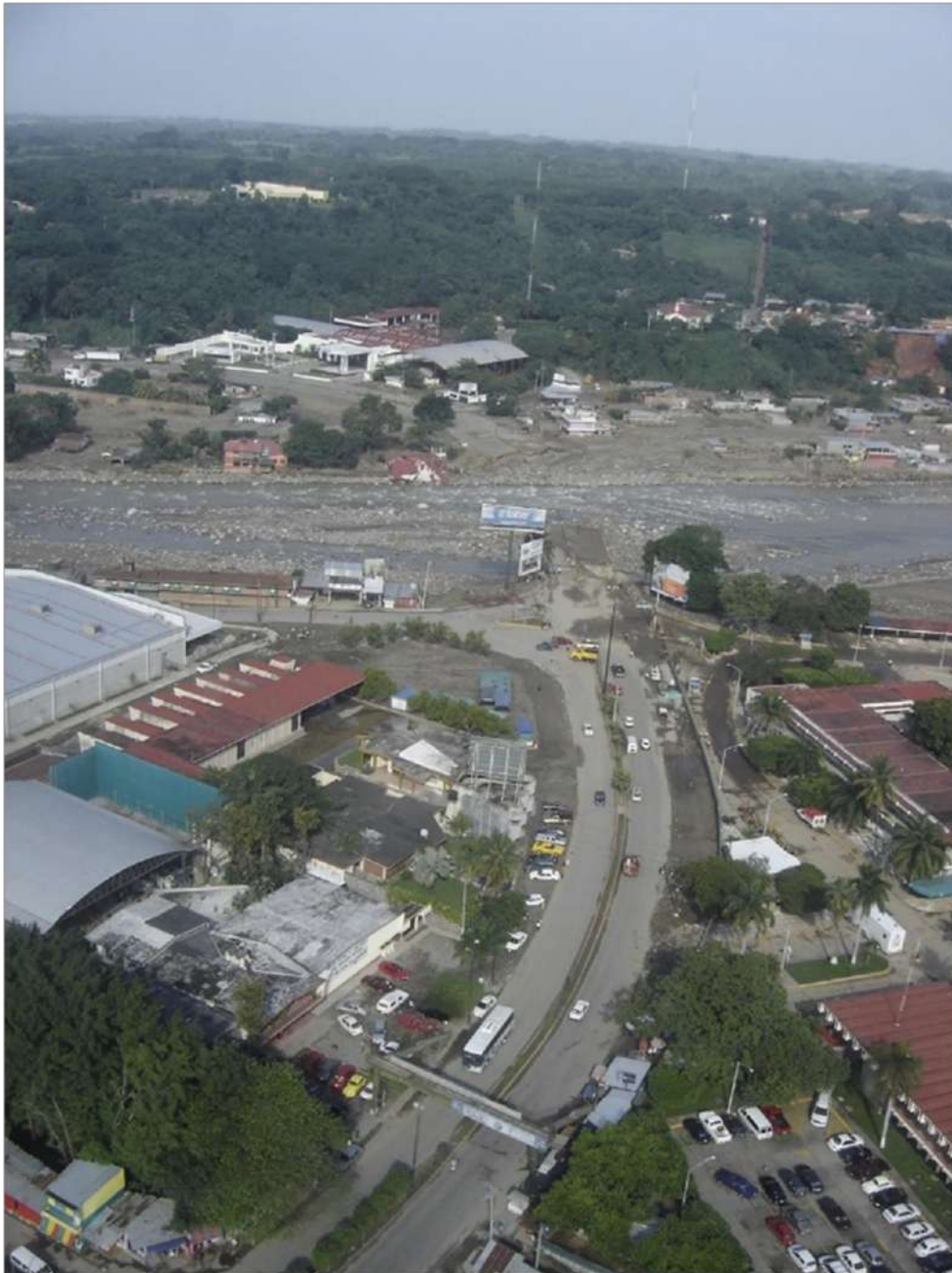
Fig 6.7 Vista del Puente colapsado sobre el río Coatán.
