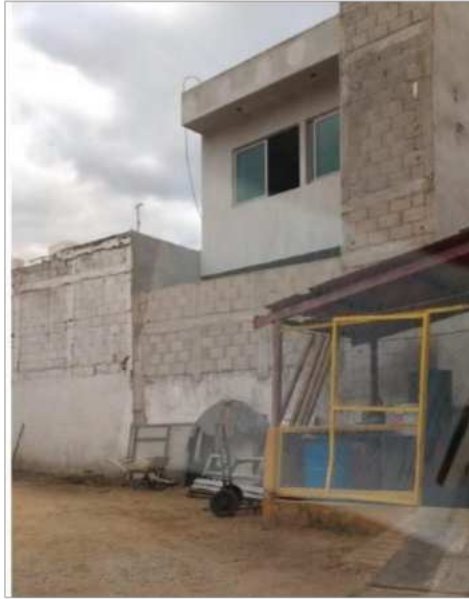
Figura 9. Sitio de almacenamiento del aceite usado dentro del taller.
