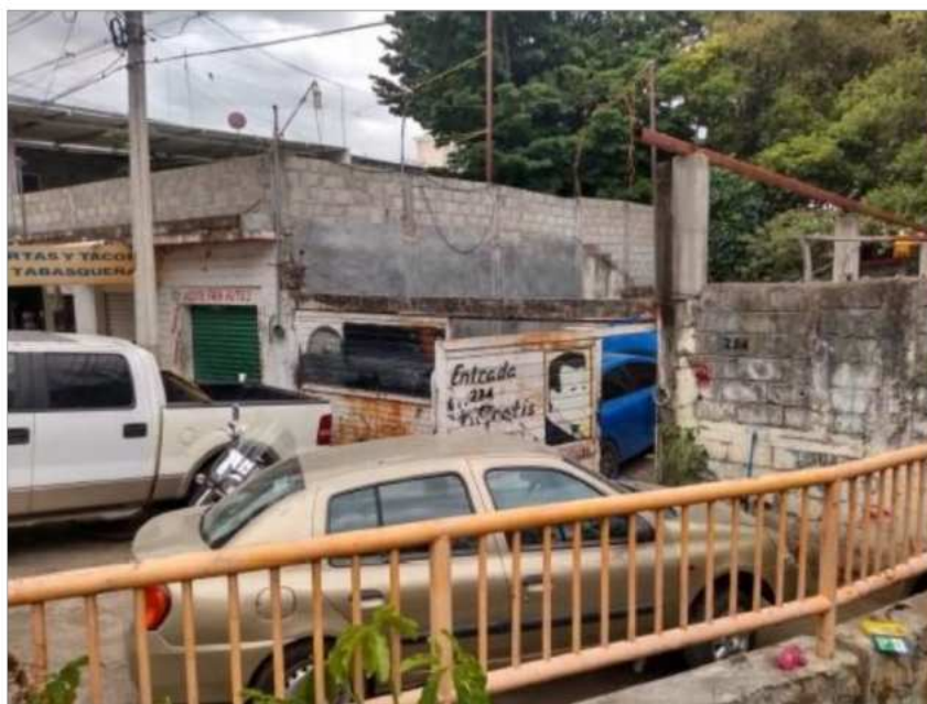
Figura 12. Taller ubicado al margen de un canal pluvial.
